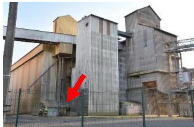
Entrée principale du silo Emplacement de la 1 ère LDV
