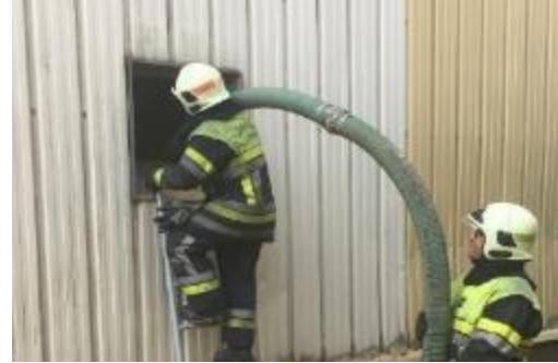
Opération de vidange par l'extérieur du bâtiment ; 2 ème jour de l'intervention
